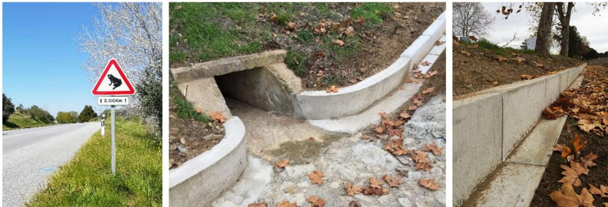
**Fig. 34 – Sinalização vertical específica para anfíbios, criada no âmbito do Projeto LIFE LINES (à esquerda) e barreiras de encaminhamento de anfíbios para PH (ao centro e à direita).**
