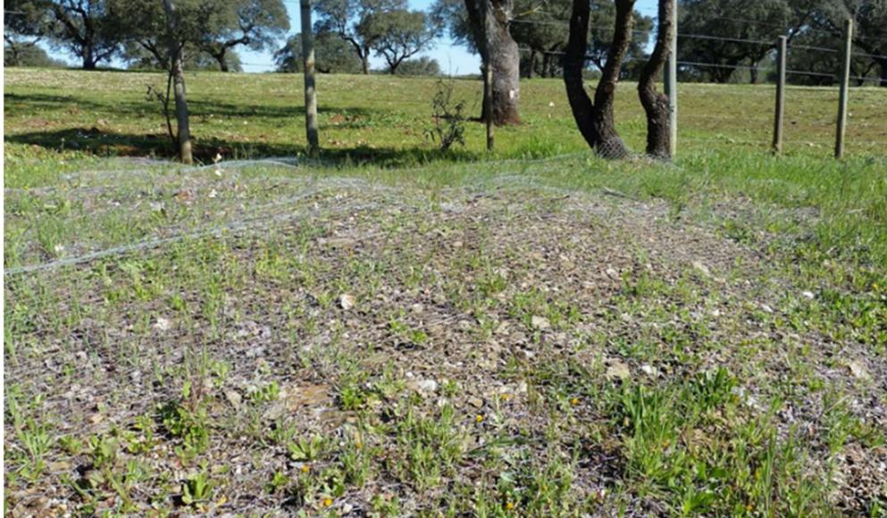
**Fig. 35 – Colocação de rede sobre os taludes da EN4, com o objetivo de impedir a sua colonização por coelhos.**
