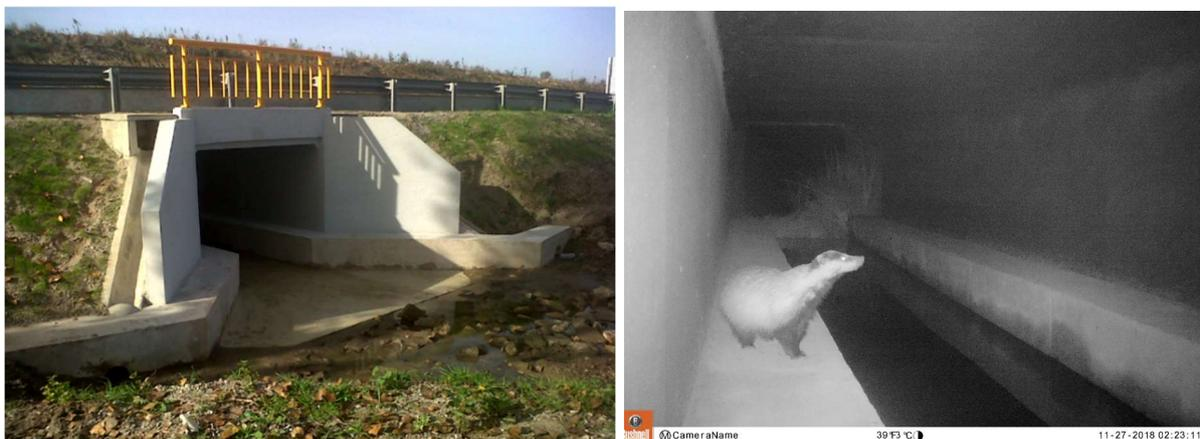
**Fig. 29 – PH na EN18, ao km 274,800, com dois passadiços secos. Na fotografia da direita é possível visualizar um texugo a utilizar um dos passadiços (fotografia captada pela Universidade de Évora durante a monitorização da PH).**
