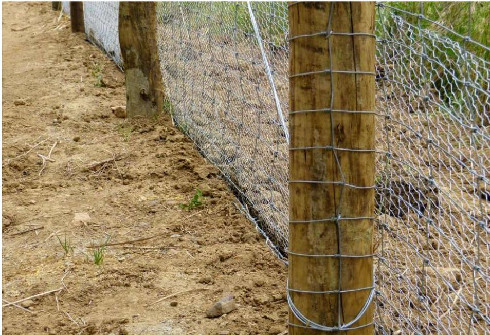
**Fig. 37 – Rede adicional, de malha apertada acoplada à vedação principal, disposta em “L”, com uma base de 50 cm enterrada.**
