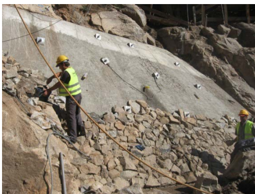
Fotografia 1 – Revestimento das estruturas de betão.
