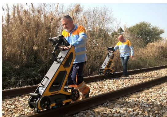
Inspeção em Contínuo c/ Equip. Portáteis
