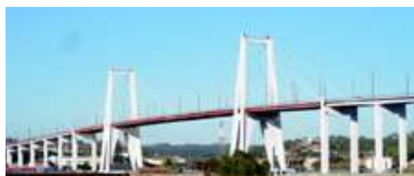
IP apresenta obra de reabilitação e reforço da Ponte Edgar Cardoso, na Figueira da Foz
