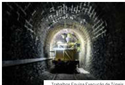
Trabalhos Equipa Execução de Túneis
