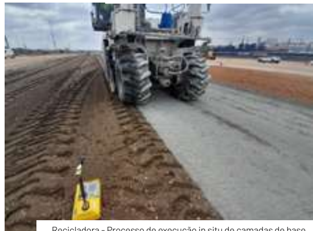
Recicladora - Processo de execução in situ de camadas de base e sub-base dos pavimentos (misturas recicladas).
