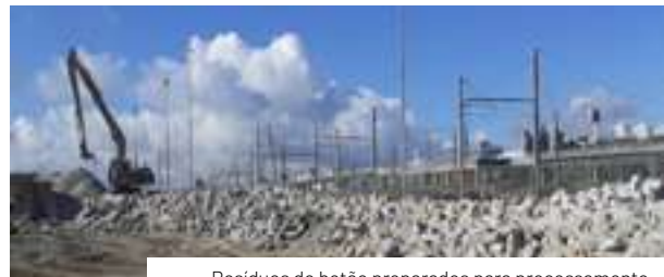
Resíduos de betão preparados para processamento
