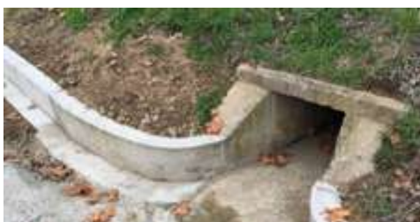
Barreiras de encaminhamento de anfíbios para Passagens Hidráulicas
