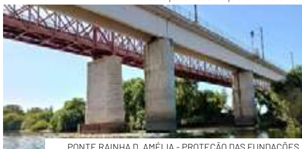
PONTE RAINHA D. AMÉLIA - PROTEÇÃO DAS FUNDAÇÕES E REABILITAÇÃO DOS PILARES
