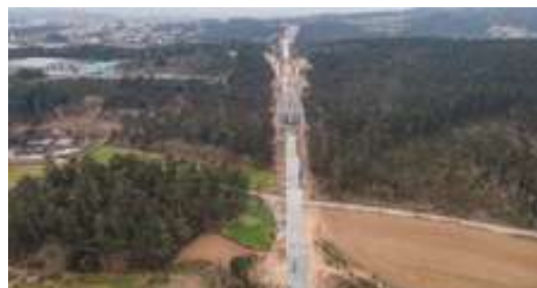
EN14 Via Diagonal / Interface Rodoferroviário Trofa – 2.ª Fase
