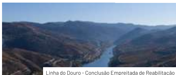
Linha do Douro - Conclusão Empreitada de Reabilitação da Superestrutura de Via
