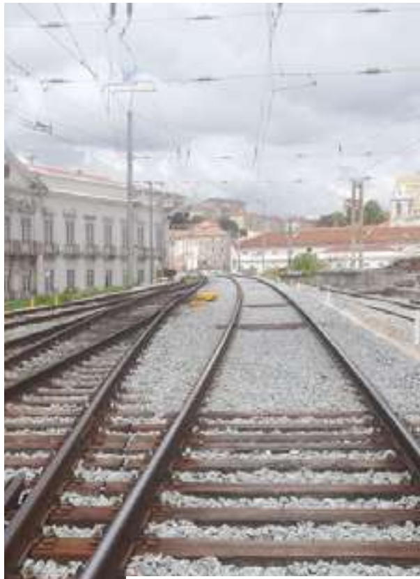
Concluída a reabilitação de via na Linha do Norte
