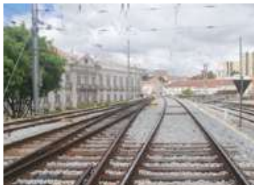
Renovação do troço Santa Apolónia-Braço de Prata Linha do Norte
