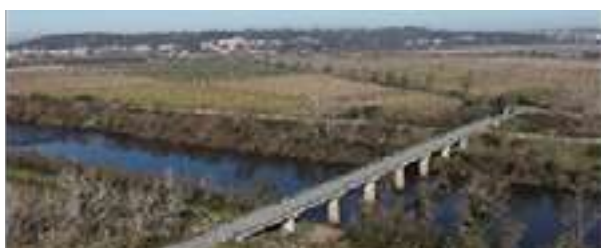
EN347 - KM17+275 - PONTE SOBRE O RIO MONDEGO. REABILITAÇÃO
