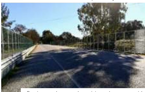
Barreiras para elevar o voo das espécies voadoras, em especial morcegos, aves de rapina noturnas e passeriformes
