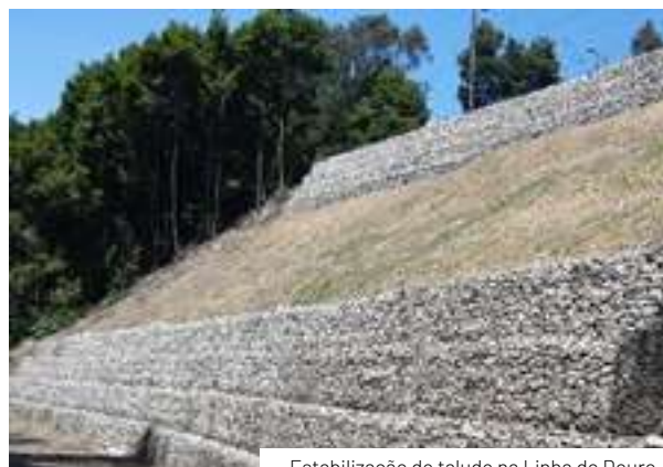
Estabilização de talude na Linha do Douro
