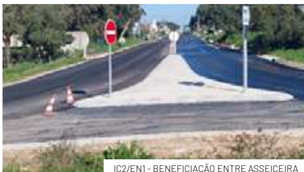
IC2/EN1 - BENEFICIAÇÃO ENTRE ASSEICEIRA (KM 65+200) E FREIRES (KM 85+500)
