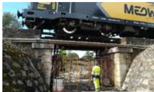
Trabalhos Equipa Execução
