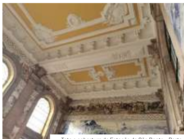
Teto e cobertura da Estação de São Bento – Porto
