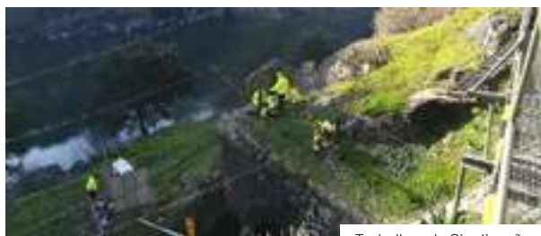
Trabalhos de Sinalização
