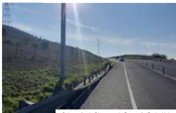
Colocação de Sistemas de Retenção Rodoviários
