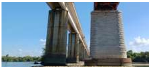
Ponte Rainha D. Amélia - Proteção das Fundações e Reabilitação dos Pilares
