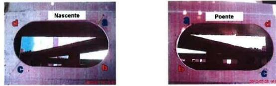
Figura 9. Referenciação das fissuras existentes nos “panel points” ímpares
