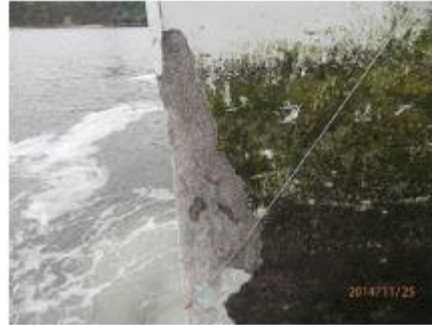
PONTO DE COLISÃO PC.1 PORMENOR
