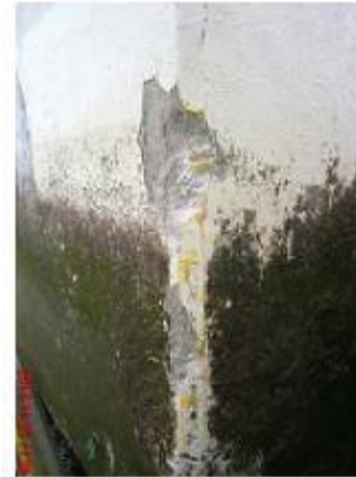
PONTO DE COLISÃO PC.2 PORMENOR
