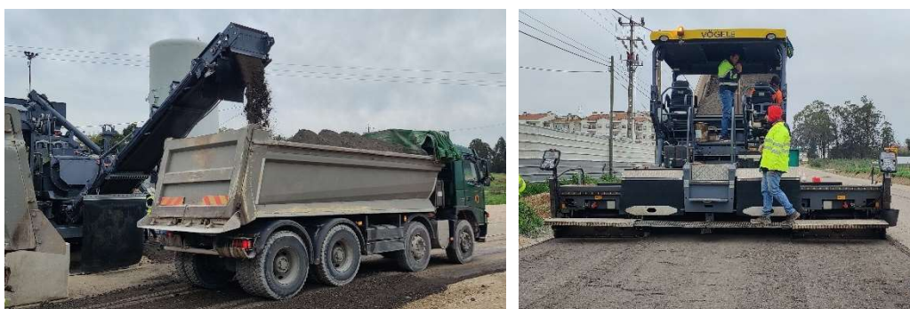
Figura 7. Carregamento dos camiões com mistura reciclada a frio pela central KMA240i (esquerda) e pavimentadora a espalhar a camada reciclada na frente de obra (direita)
