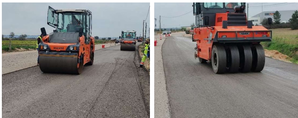
Figura 8. Compactação inicial da camada reciclada com cilindro de rastos lisos (esquerda), concluindo-se a compactação com um cilindro de pneus (direita)
