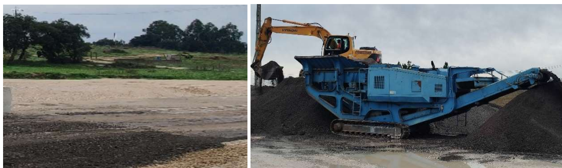
Figura 6. Central móvel KMA240i de produção da mistura reciclada a frio (esquerda) e equipamento utilizado para desagregação e crivagem do material fresado (direita)
