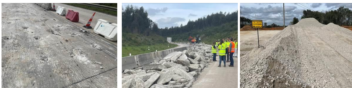
Figura 3. Processo de demolição das lajes de betão e agregados reciclados de betão
