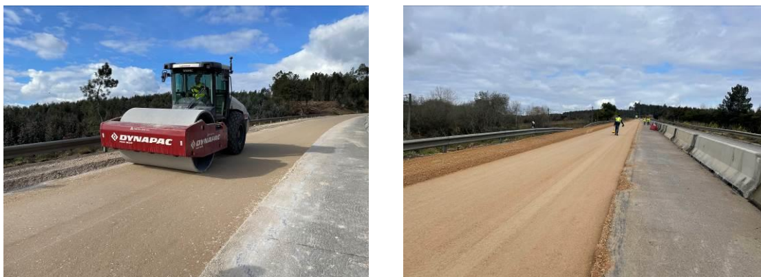
Figura 4. Processo de compactação e controle de qualidade do trecho experimental
