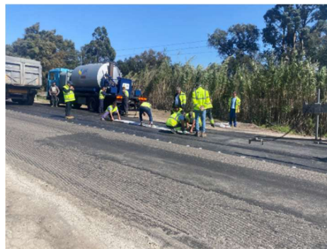
Figura 14. Recolha de amostras (esquerda) e preparação para posterior recolha de lajes (direita)
