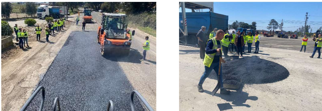
Figura 12. Aplicação de SMA10S com RAR – “Trecho Experimental” (esquerda) e recolha de amostras junto à central de fabrico (direita)
