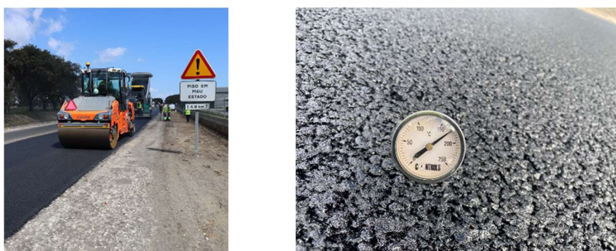
Figura 13. Aplicação e compactação (esquerda) e temperatura de compactação (direita)
