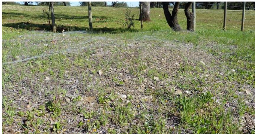
**Fig. 34 – Colocação de rede sobre os taludes da EN4, com o objetivo de impedir a sua colonização por coelhos.**
