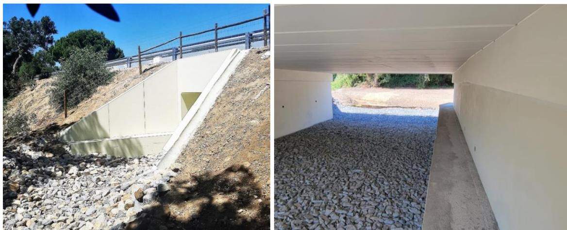
**Fig. 26 – Passadiços de fauna implementados no IC1 aos km 548,2 (esquerda) e 583,5 (direita).**
