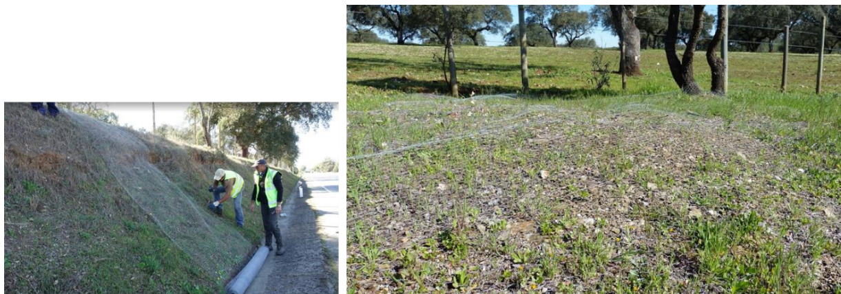
Fig. 20 – Colocação de rede sobre os taludes da EN4, aproximadamente entre os km 88,315-88,815 e 130,660-131,160, com o objetivo de impedir a sua colonização por coelhos.
